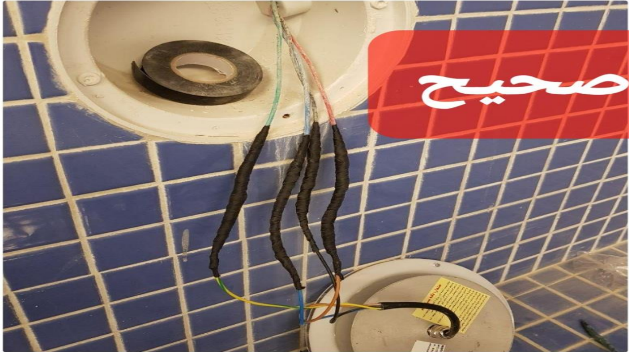
طریقه صحیح آبیندی کابل چراغ با نوار آپارات
