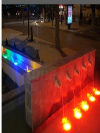
نصب در کف آبنما بصورت روکار
