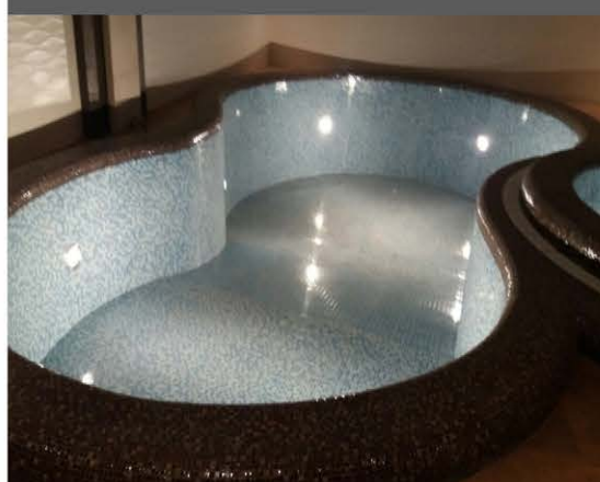
نصب در دیواره استخر بصورت روکار
